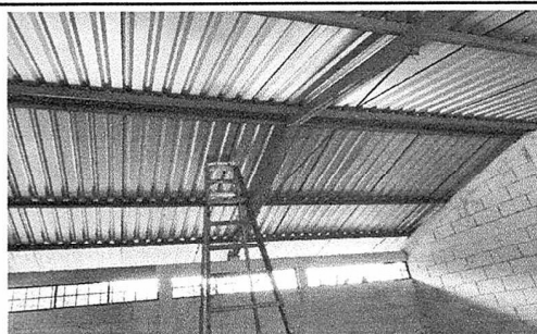
Foto 2: Sustitucion de entechado y lamina de las aulas de la escuela.
